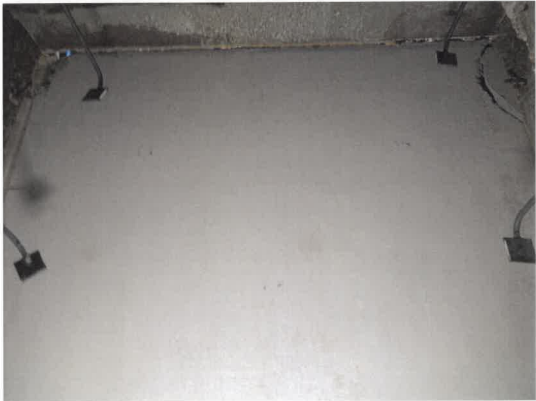
Das Bild entstand am Tag nach der Brandprüfung (FS).
