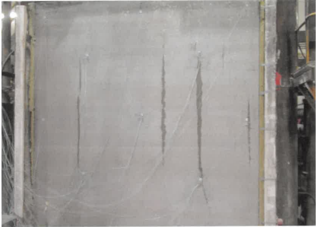
90. Minute: Kondenswasseraustritt an neuen vertikalen Rissen sichtbar (FA).
