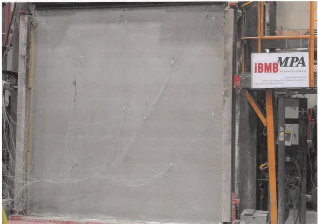
43. Minute: Kondeswasseraustritt an den Risskanten (FA).
