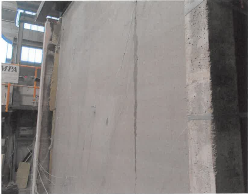
57. Minute: Wasserdampfaustritt am Riss zwischen den Messstellen 3 und 5 (FA).
